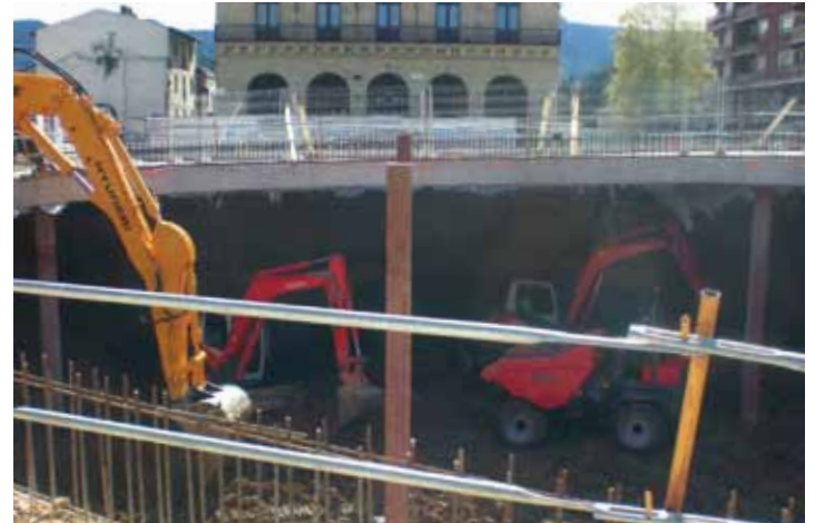
Para poder hormigonar la losa sobre ellos, se les pega un corte a la altura precisa y se les suelda un conjunto de chapón superior y cartelas sobre los que apoyará la futura losa de plata baja (o la plaza, la calle propiamente dicha)
