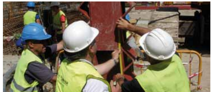
Comprobación de cotas, para verificar que se ha introducido lo necesario
