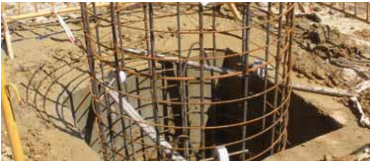
Armadura de pilote suspendida en su ubicación definitiva.
