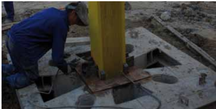
Siempre con la ayuda del topógrafo. Cuando se logra la posición “vertical” se sueldan cuñas y chapas para mantenerla durante el hormigonado
