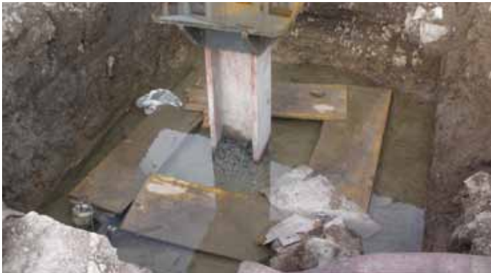
Para poder hormigonar la losa sobre ellos, se les pega un corte a la altura precisa y se les suelda un conjunto de chapón superior y cartelas sobre los que apoyará la futura losa de plata baja (o la plaza, la calle propiamente dicha)
