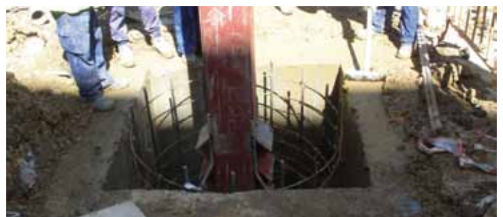
Una vez soldado se introduce ya en su totalidad, (se va para abajo)
