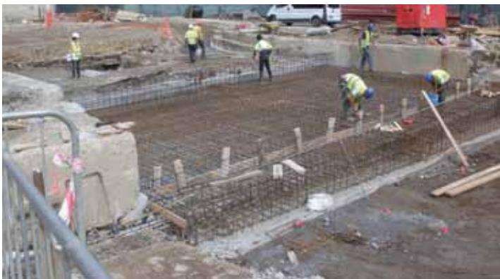
Armado de losas sobre plástico y hormigón de limpieza
