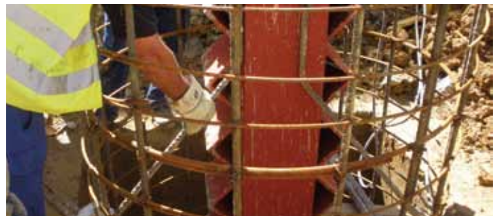
Detalle de la unión pilar-armadura mediante el “soldeo” de barras en forma de “Z”
