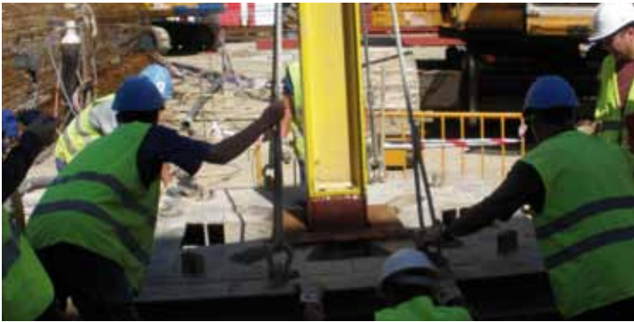
Hasta que el centrador (el embudo gigante) queda apoyado en el murete guía
