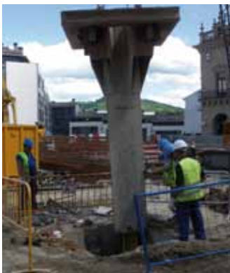
Metiendo el centrador por la cabeza del pilar, que se ve de amarillo
