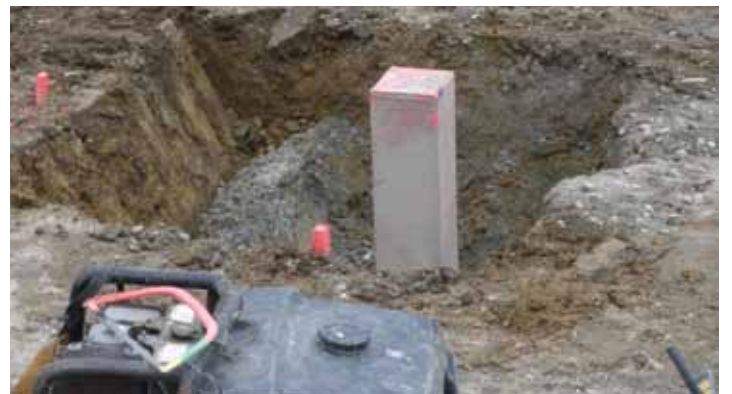
Después se empieza la excavación hasta encontrar los perfiles metálicos ya metidos
