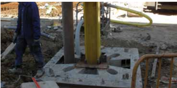
Después se empieza la excavación hasta encontrar los perfiles metálicos ya metidos
