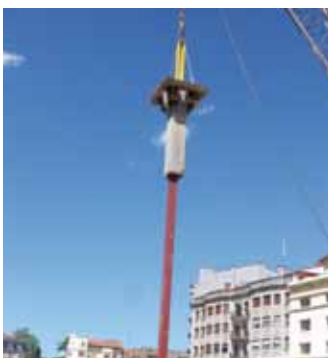
Armadura de pilote suspendida en su ubicación definitiva.
