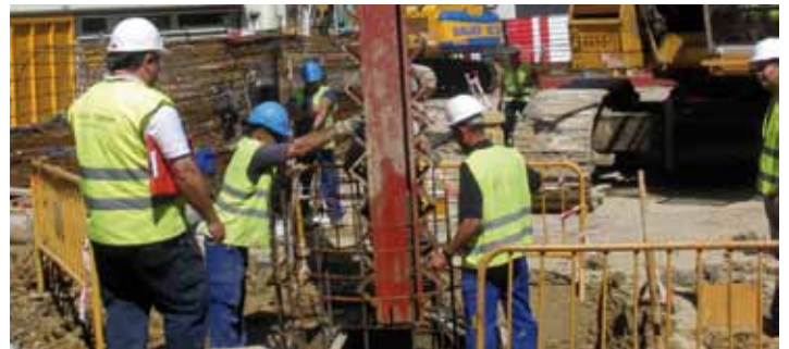
Introducción del pilar en su armadura de pilote
