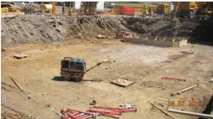
Se vuelve a rellenar hasta que esos chapones que se han soldado quedan a ras con el hormigón de limpieza que se va a echar y que servirá de encofrado perdido de la losa
